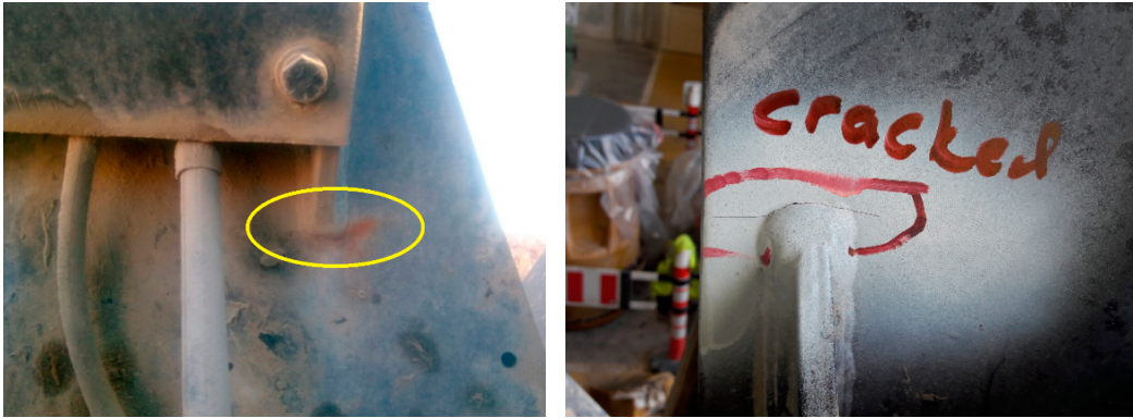
Resim 3. Sahada VT Kontrolü yapılan bir İş makinesinde çatlak şüphesiyle MT kontrolü yapılması sonucu ortaya çıkan çatlak ve çatlağın durumu.
