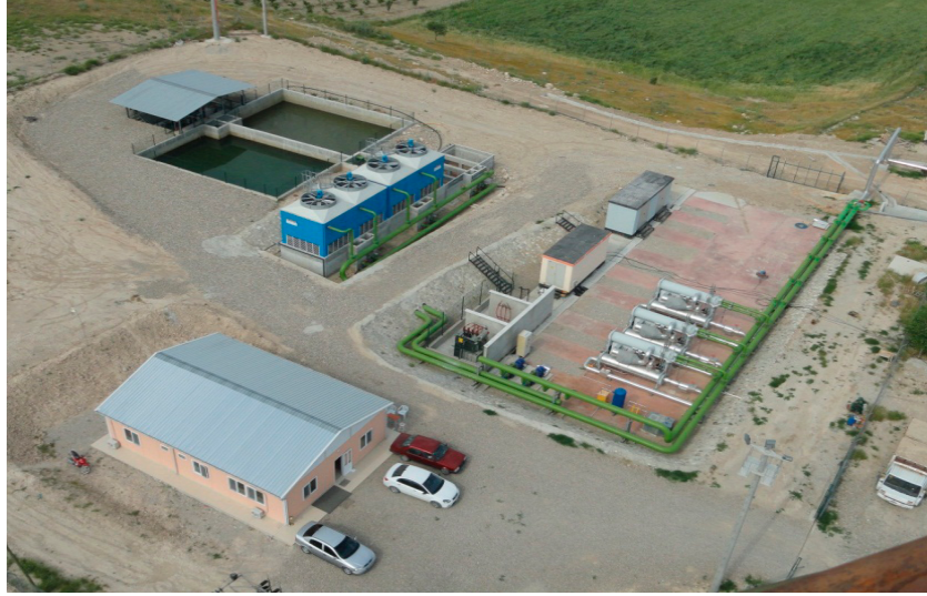
Şekil 1. Jeoden JES santral sahası [1]
