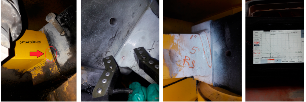
Resim 6.Orta üst göbük plakasında çatlak şüphesi olan bir yükleyicinin kontrol
