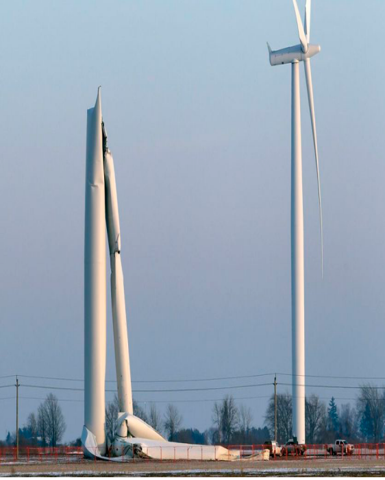
Şekil 4. Rüzgar türbini kanatlarında meydana gelen büyük hasarlar (Shreve, 2018; NWW, 2016; NNYW, 2018;
