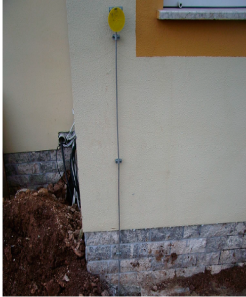
Şekil 13. Test klemensi ve iniş iletkeni [4]
