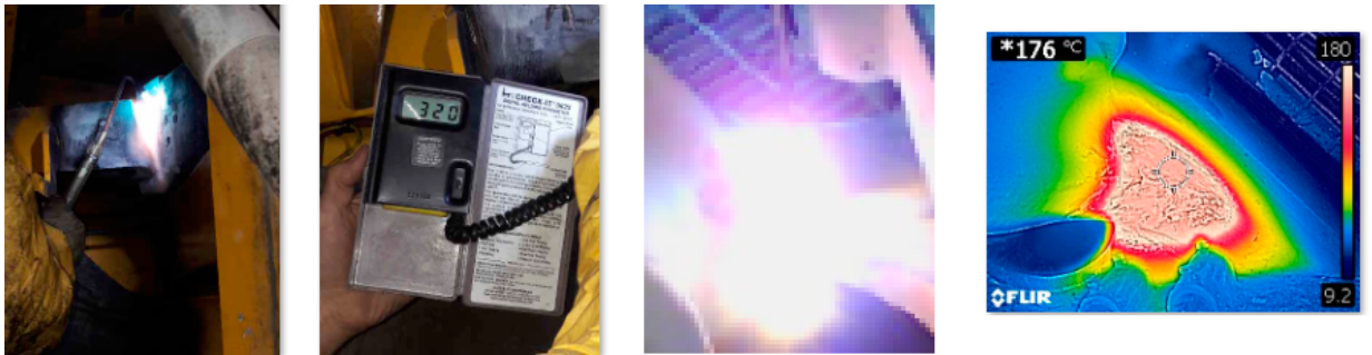
Resim 8. Bir tamir işleminde, ön tavlama, karbon ark ile çatlığın açılması ve ısı kontrolü örneği
