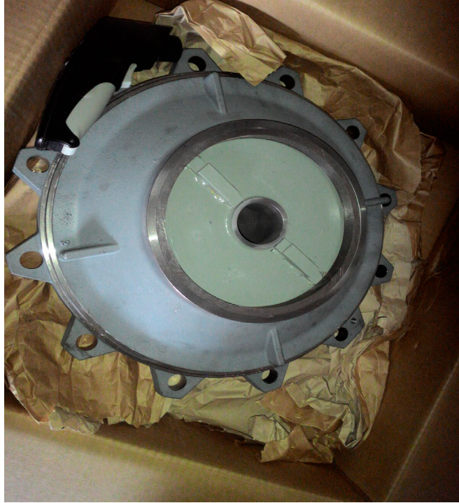
Resim 5: Pompaya sonradan eklenen vorteks kırıcılar
