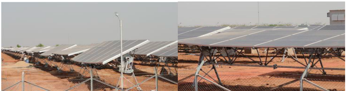
Şekil 3.8. Dizi Montaj Donanımı Sıklığının Kontrol Edilmesi (GSES, 2016)
