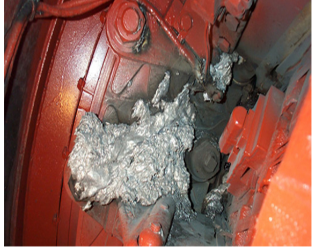
Şekil 4. Rüzgar türbinlerinin rotor sargılarında meydana gelen arızalar (EP, 2013)
