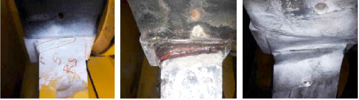
Resim 9. Bir tamir işleminde, oluşan çatlakın tamamen yok oluncaya kadar kaynak ağzı açılması ve MT kontrol ile doğrulanması örneği
