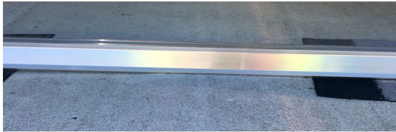
Şekil 1.2. Rafin Doğrudan Çatı Yüzeyine Temasının Kesilmesi (NREL, 2016)
