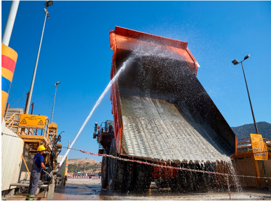
Resim 1. Kaya Kamyonu Yıkama İşlemi
